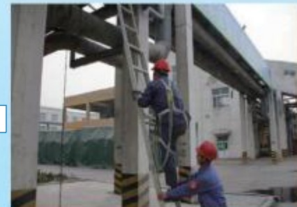
保障安全再进行作业
